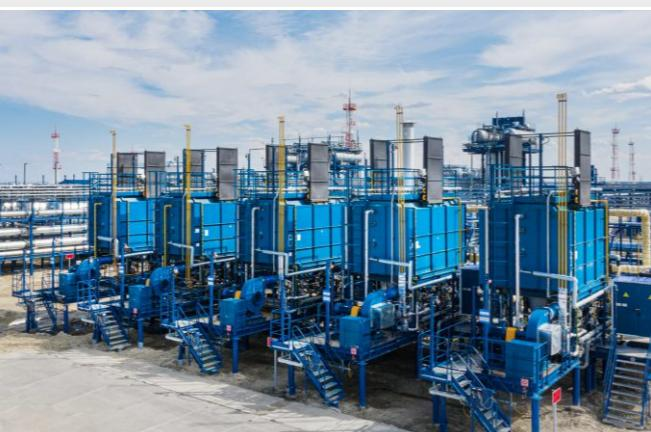
**Блок трехфазных сепараторов**
